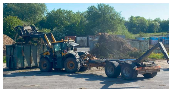
Evacuation des souches et rondins – déchetterie de Feuquières
