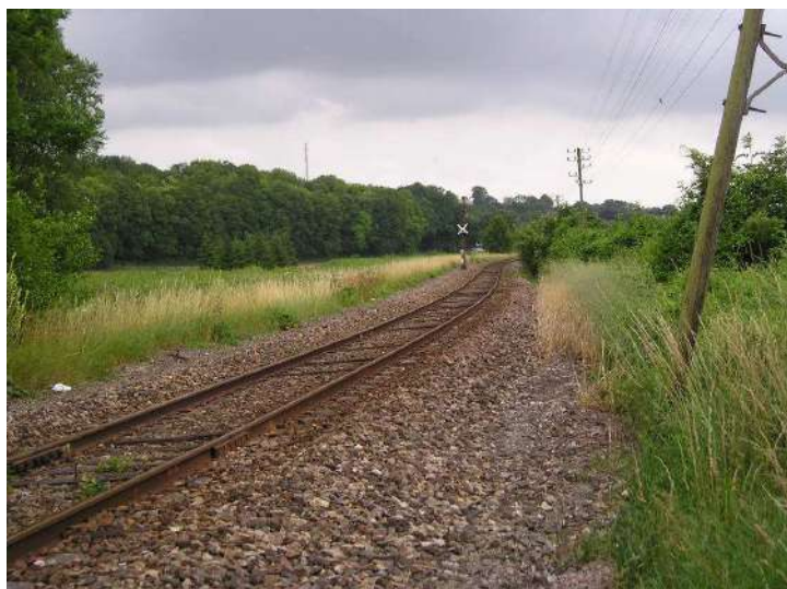
Voie ferrée en arrière de la zone 1AUe
