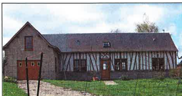
Un bel exemple de réhabilitation du bâti traditionnel
